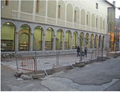
Obres aturades al carrer del Claustre
